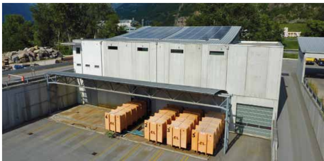
La stazione di trasbordo rifiuti urbani della Comunità Comprensoriale Burgraviato
